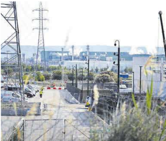
Obras en el centro de datos de El Burgo, con la fábrica de Saica al fondo.
