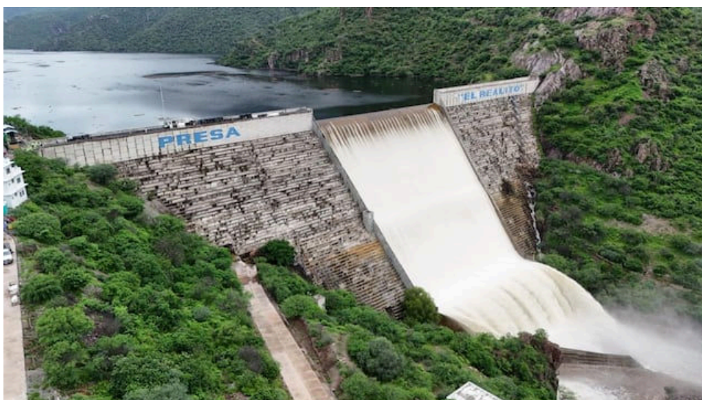
Obras de rehabilitación del sistema "El Realito"
