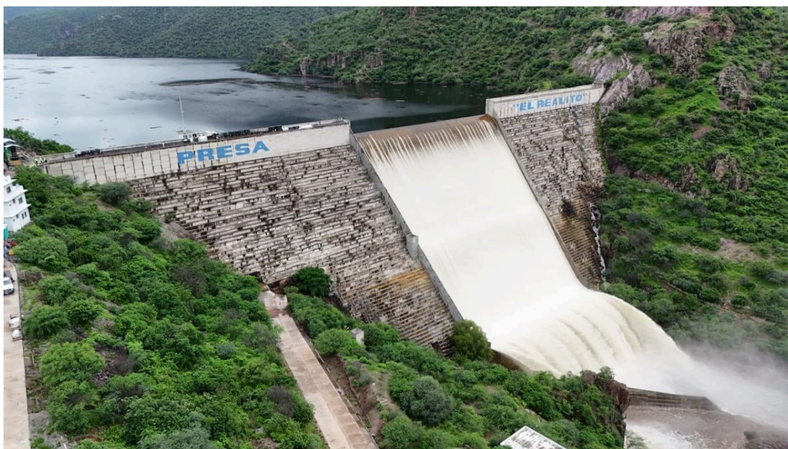
Obras de rehabilitación del sistema "El Realito"
